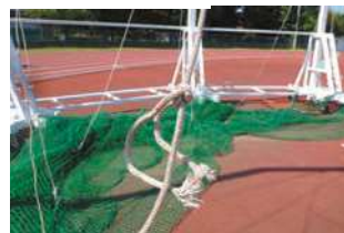
ネット昇降用ロープほつれ
